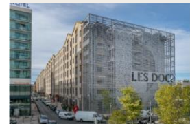
Les Docks Marseille 62 000m 2 de bureaux et commerces
