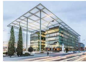
El Portico Madrid 21 000 m 2 de Bureaux
