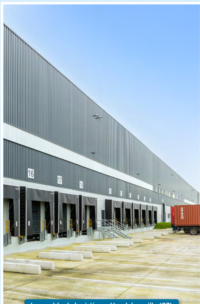
Immeuble de logistique, Heudebouville (27)
