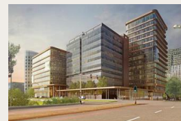
Atrium Amsterdam 60 000m 2 de bureaux
